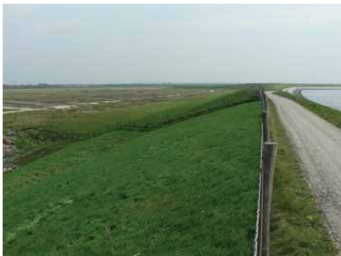
Figuur 3.7. Oosterscheldefietspad op buitendijk bij Borrendamme, 18 april 2008 (TS).
